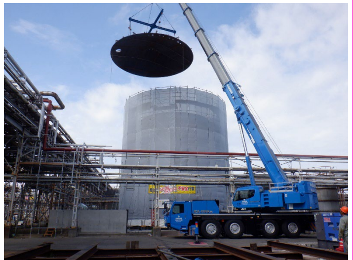
タンク屋根取り付け中 奥のタンクに設置
