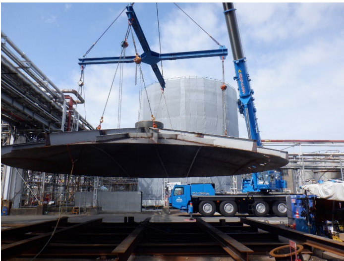
タンク屋根取り付け中 奥のタンクに設置
