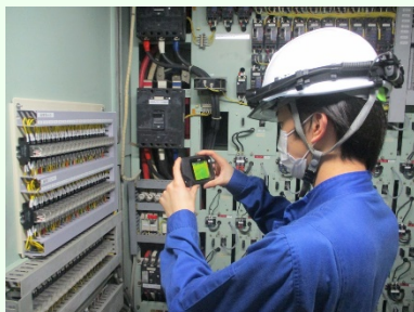
制御盤撮影風景
