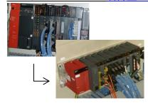
機器事業本部電製部では、配電盤・制御盤のリニューアルにもお応えしています。一括交換が困難な分電盤内部機器の総入れ替えへの対応や、昨今多く引き合いを頂戴するシーケンサ(PLC)およびサーボアンプなどのリニューアルにも多くの実績を有しております。弊社はこのノウハウを活かし、最適な制御環境(機器選定やプログラム更新)の構築に、ソフト・ハードの両面で、お客様のご要望にお応えすべくご提案をいたしますので是非お問い合わせ下さい。(写真は三菱PLC A→Q への更新)
