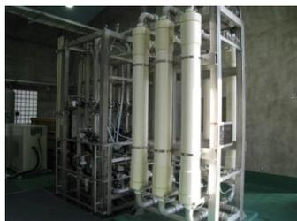
弊社は、UF（Ultra Filtration）膜や中空糸により原水をろ過して塩素では死滅しないクリプトスポリジウム（ヒトを含む脊椎動物の消化管などに寄生）等の原虫を物理的に確実に除去し、安全・安心な浄水を安定的に供給できる浄水場設備に実績があります。
