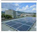
プラント事業部では、工場屋根などに設置する数百kWレベルの太陽光発電設備工事の実績を有しておりますが、この度、本社ビル屋上に太陽光発電システム (10.71kW) を設置し、9月19日から発電を開始致しました。今回設置のパネルの取り付け方法は、傾斜角0度(平面屋根に水平に設置)であり、四季を通じてモジュール面に受光する時間が長い、風の影響を受けにくいなどの特徴を有しております。発電量はわずかではありますが、これを機に、社員一人ひとりの省エネマインドの更なる向上を期待しております。
