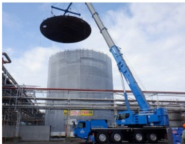
屋外貯槽設置工事
