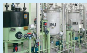
スキッド化工事
